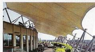
DRINK CON VISTA nel nuovissimo bar Suite 10th Floor, a Milano.
